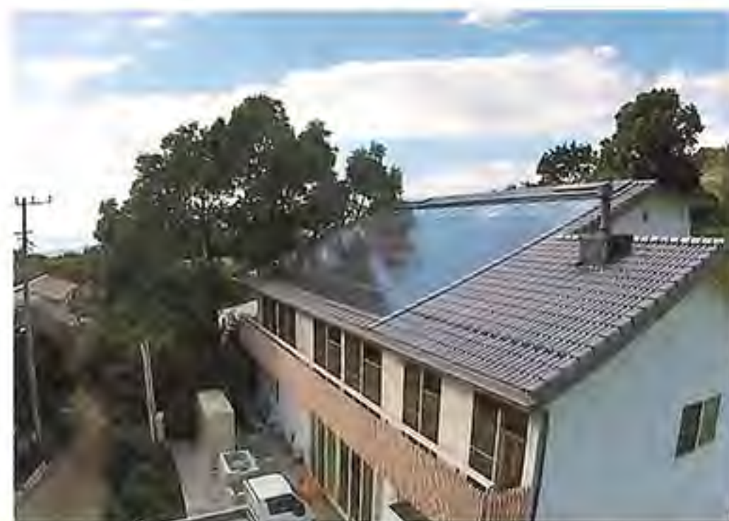
函南の農場に建てられたOMソーラーの加工工場。
